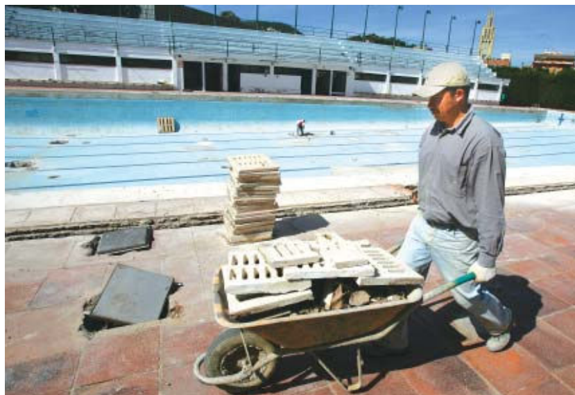
Un operari treballa a les obres de millora a la piscina del carrer Bonavista | SANTI ROMERO
